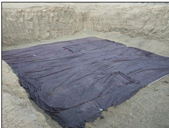
渗滤液池底部防渗处理
