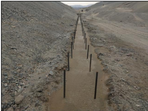
坝体防冲刷钢筋混凝土浇筑
