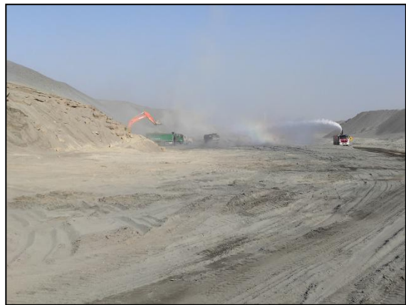
消防车喷水降尘
