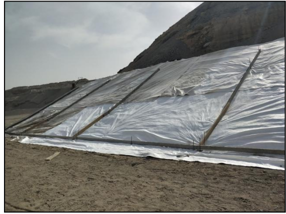
坝体铺设防渗土工布
