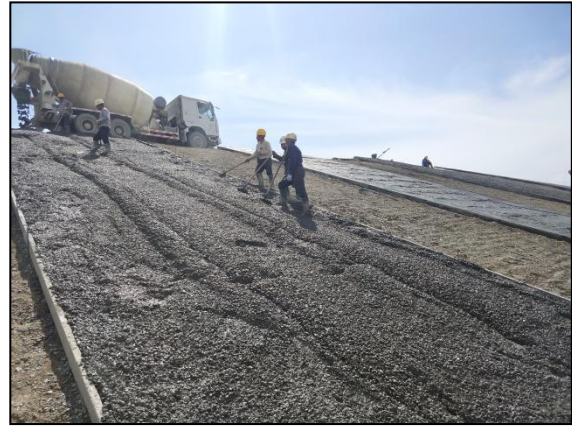
坝体混凝土浇筑
