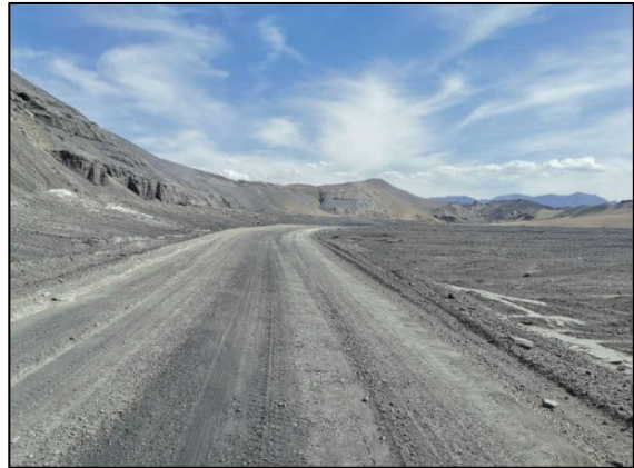
施工进场道路
