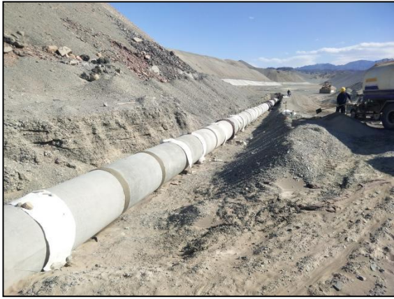
渗滤液导排管施工
