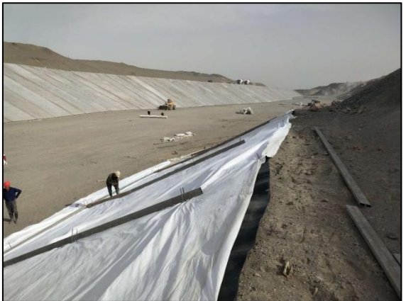
坝体防渗膜施工
