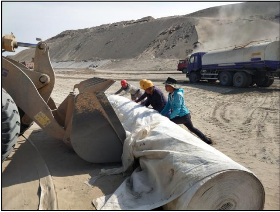
填埋场地底部铺设防渗土工布
