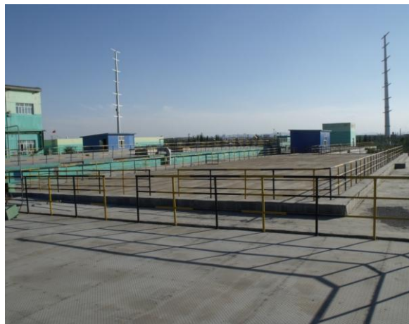
2#污水事故池; 消防事故池
