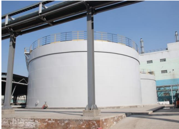
1#污水事故池; 消防事故池
