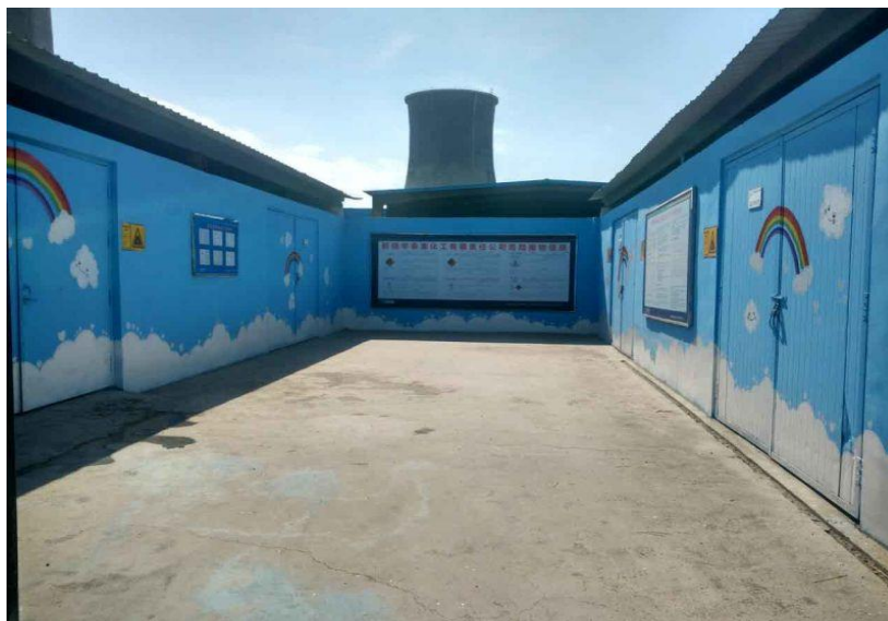
华泰公司危险废物储存中心
